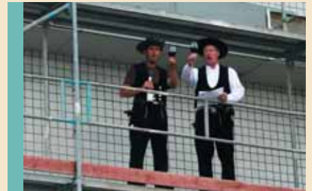
Wie bei jedem Richtfest durfte auch bei der Klinik für Geriatrie der Richtspruch nicht fehlen.
